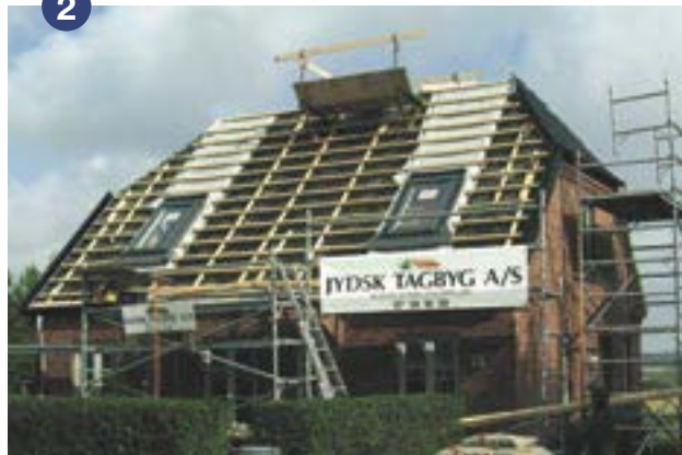
Montagen af stålpladerne tager ikke lang tid. Lægterne monteres direkte på de gamle tagplader
